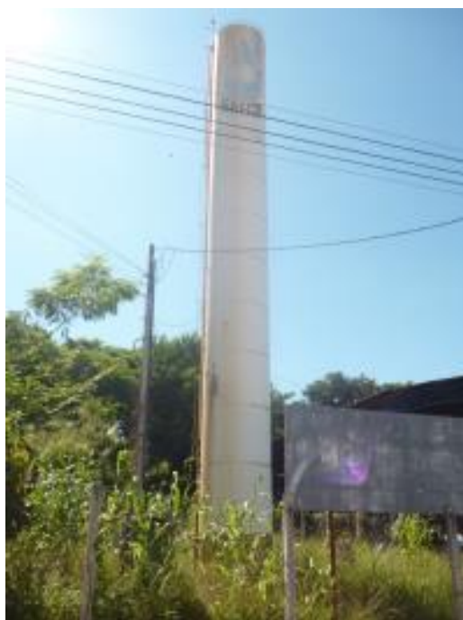
Foto 4.21 – Reservatório R-13 (Bairro Taquari Ponte)
