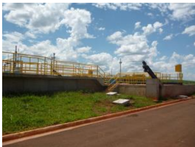
Foto 4.28 – Unidades de Tratamento Preliminar
