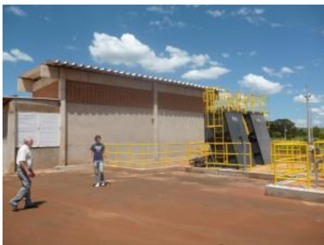
Foto 4.25 – Estação Elevatória de Esgotos Final (EEEF)
