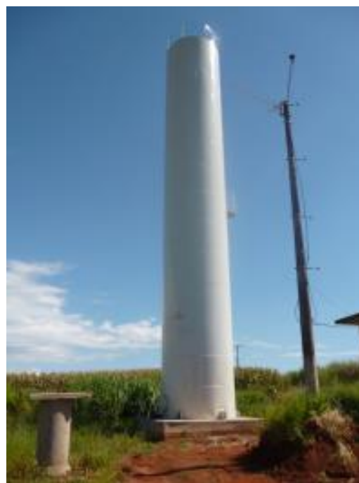
Foto 4.22 – Poço Profundo P-02 e Reservatório R-14 (Bairro Taquari Ponte)
