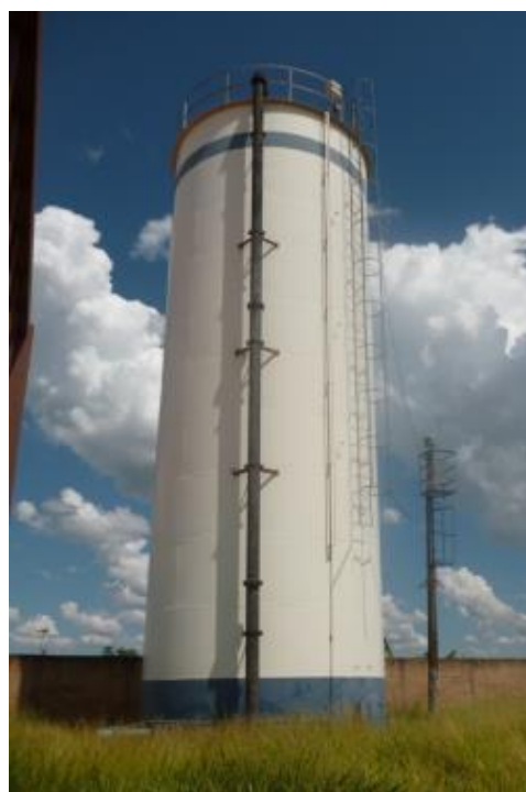
Foto 4.16 – Reservatório São Joaquim
