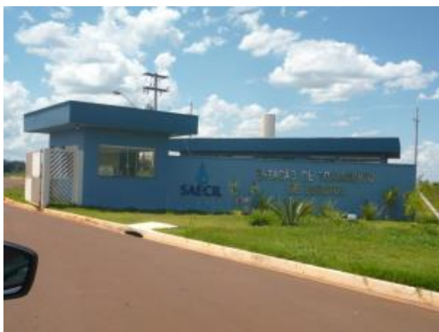
Foto 4.27 – Entrada da Estação de Tratamento de Esgotos de Leme
