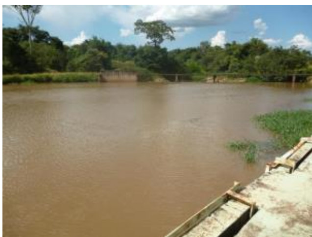
Foto 4.1 – Barragem de Nível do Ribeirão do Roque
