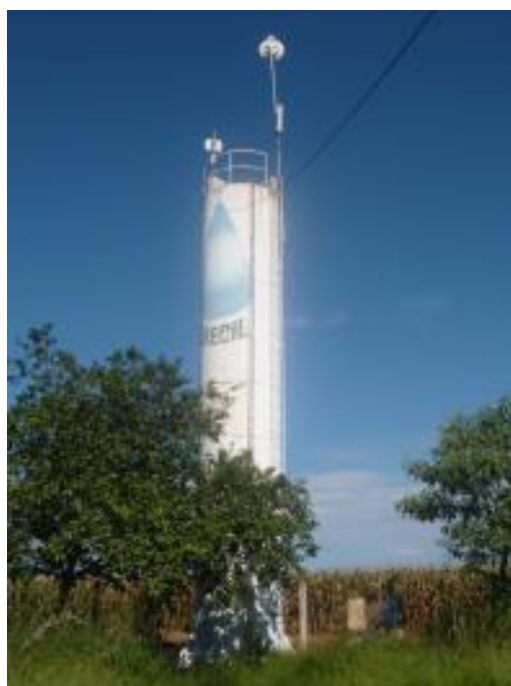
Foto 4.24 – Reservatório R-17 (Bairro do Caju)
