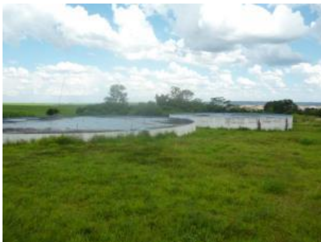
Foto 4.13 – Centro de Reservação da ETA
