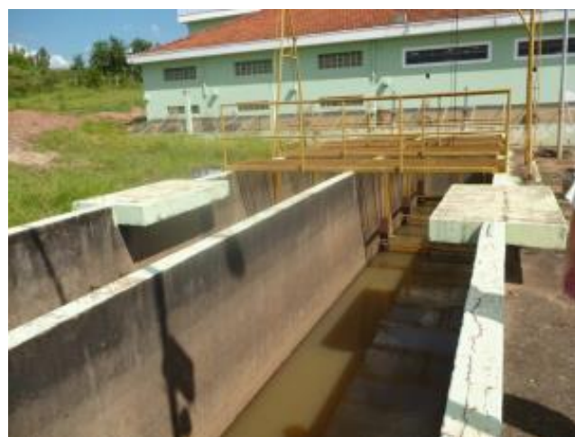
Foto 4.2 – Canal de Derivação para Poço de Sucção da EEAB1
