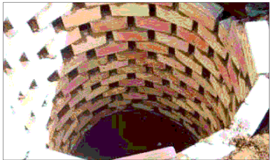
ILUSTRAÇÃO PAREDE SUMIDOURO BLOCO MACIÇO INTERCALADO
