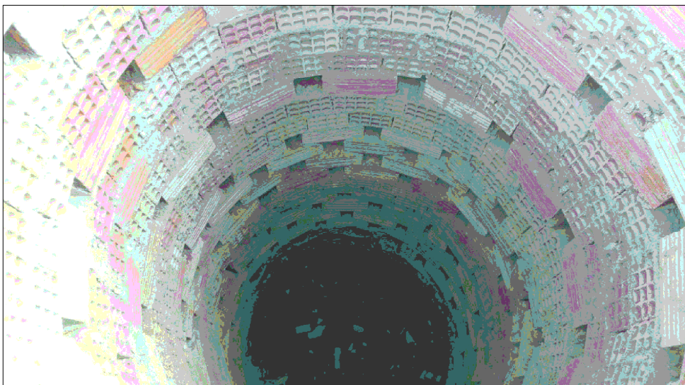
ILUSTRAÇÃO PAREDE SUMIDOURO BLOCO FURADO
